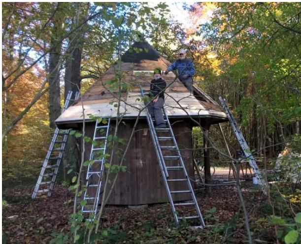
Die Hütte wird neu eingedeckt.
