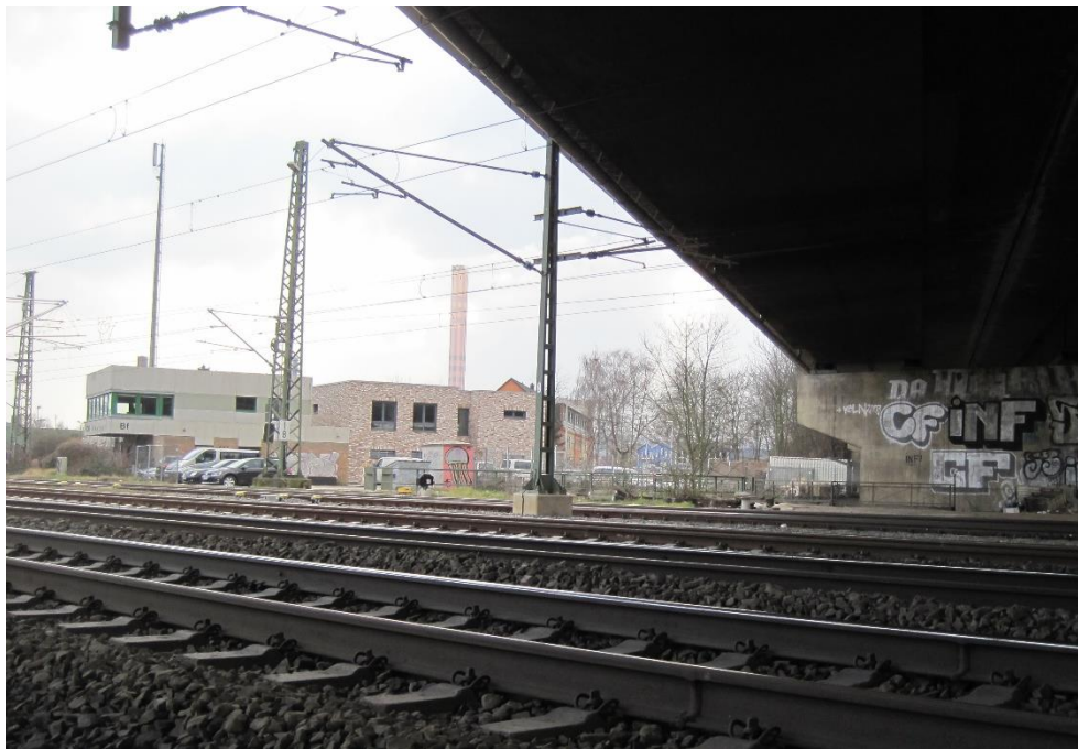
Abbildung 3.5 Gleisanlagen der DB und Stellwerk Bonn Bf
