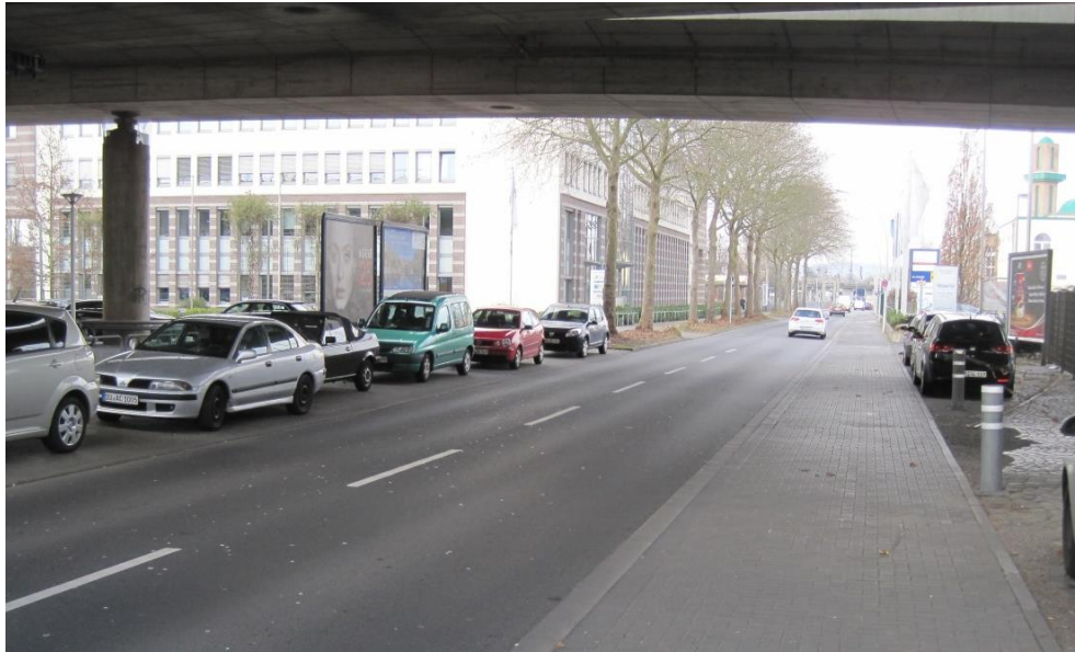
Abbildung 3.12 Brühler Straße – Unterführung der A 565
