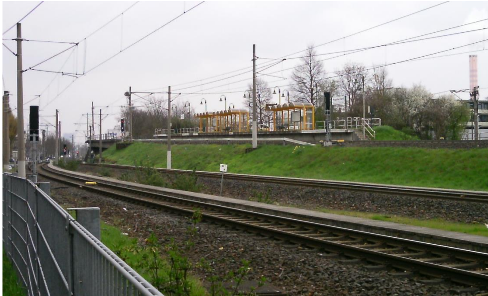
Abbildung 3.6 Bahnhaltepunkt „Propsthof Nord“ der Stadtbahn östlich der A 565
