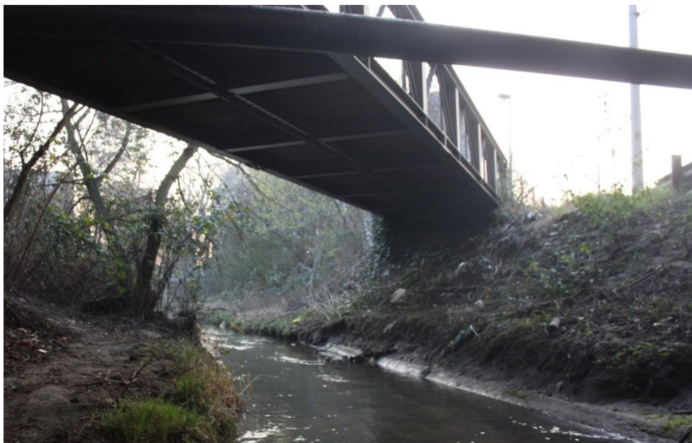
Abbildung 3.16 Rheindorfer Bach – Unterquerung Geh- und Radwegbrücke
