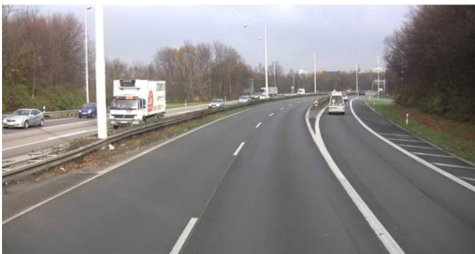
Abbildung 3.46 Anschlussbereich AK BN-Nord (Blickrichtung Norden)
