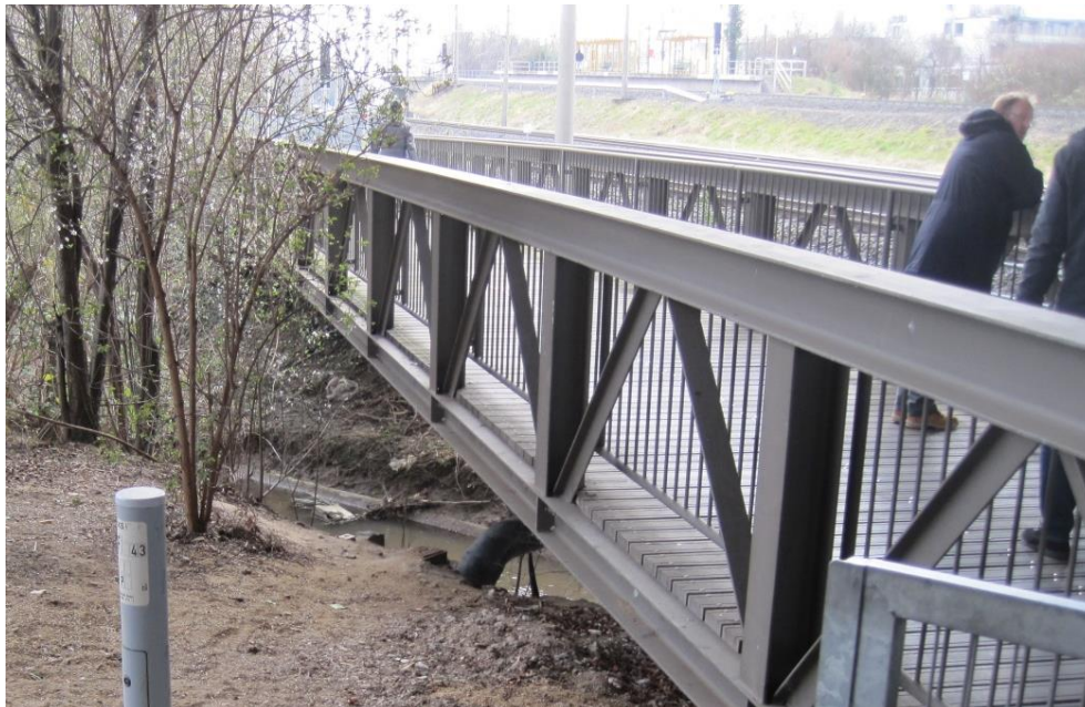
Abbildung 3.14 Geh- und Radwegbrücke Rheindorfer Bach
