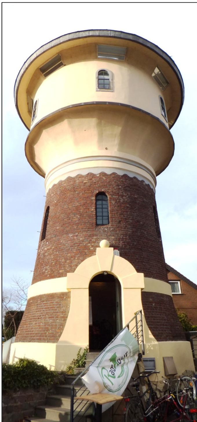
Der Breniger Wasserturm
