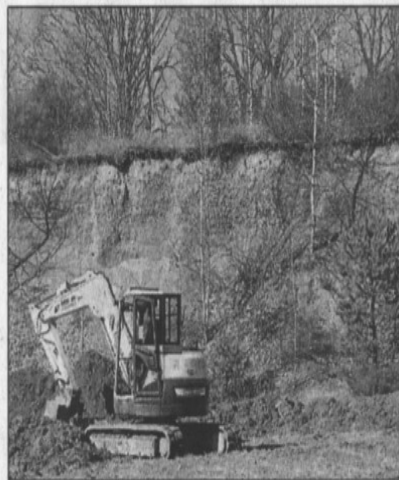
Die Herrichtung der Gruben hat bereits begonnen. FOTO: HENRY
