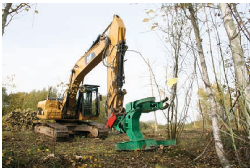
Zur Sanierung der Gruben wurde auch schweres Gerät eingesetzt.
